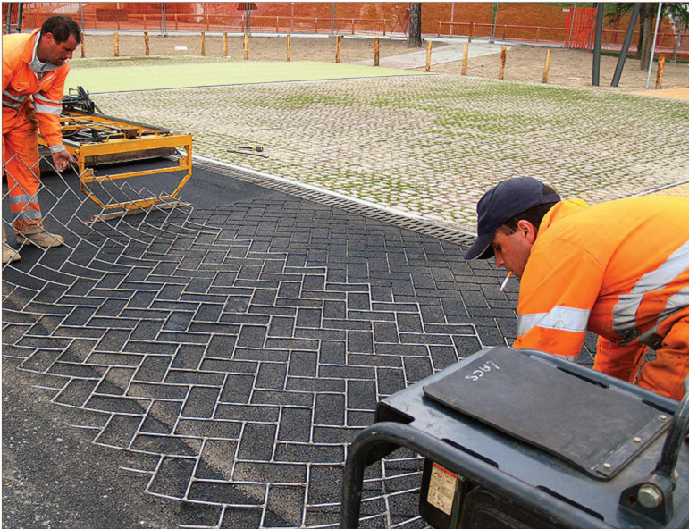
Fase tecnica di realizzazione delle fughe
