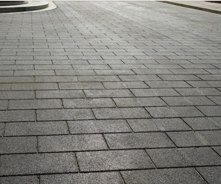
Effetto finale di asfalto stampato
